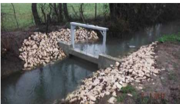
Figure n°III.2. Vue de l'ouvrage de mise en charge du fossé avec le coude PVC immergé et de la connexion coté frayère
