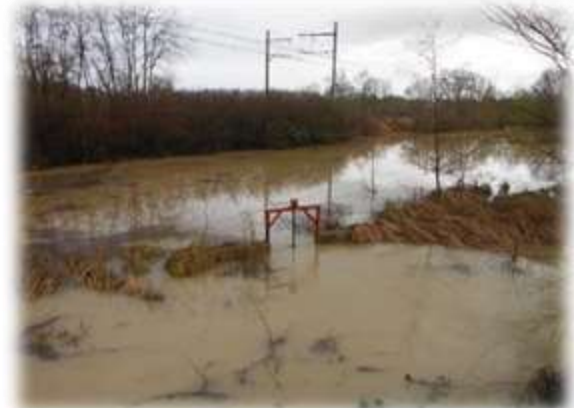
Figure n°III.4. Vues du clapet d'alimentation avec anti retour à Polliat et d'un niveau d'eau supérieur à la vanne fermée à Mézériat
