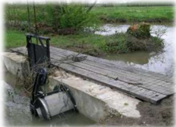
Figure n°III.4. Vues du clapet d'alimentation avec anti retour à Polliat et d'un niveau d'eau supérieur à la vanne fermée à Mézériat
