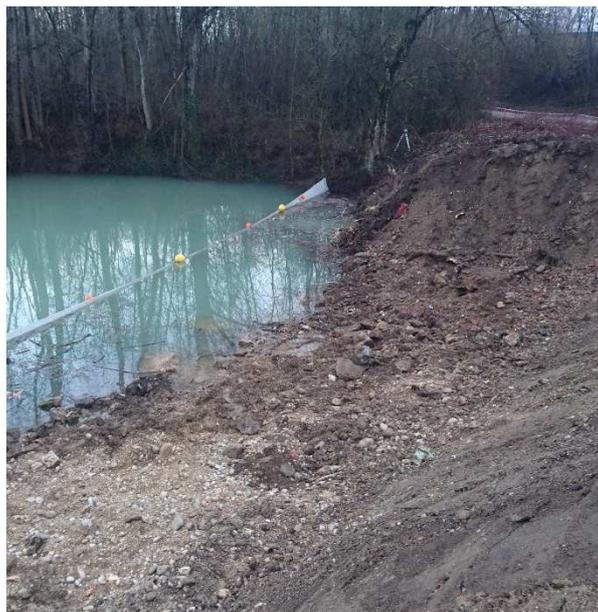
*Figure 9 : Mise en place d'un filet pour éviter la propagation de la Renouée durant la phase travaux*
